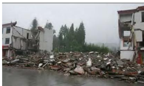
ภาพที่ 3 สภาพอาคารเสียหายหลังเหตุการณ์แผ่นดินไหวที่มณฑลเสฉวนในประเทศจีน [4]
